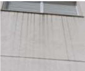
Figura 5 Manifestação patológica 05 Manchas na fachada provenientes da pingadeira
