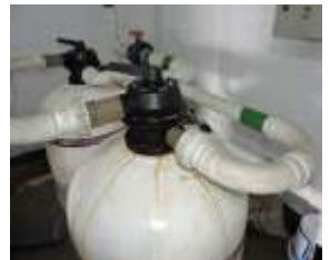
Figura 8 Manifestação patológica 08 Vazamento nos filtros da piscina
