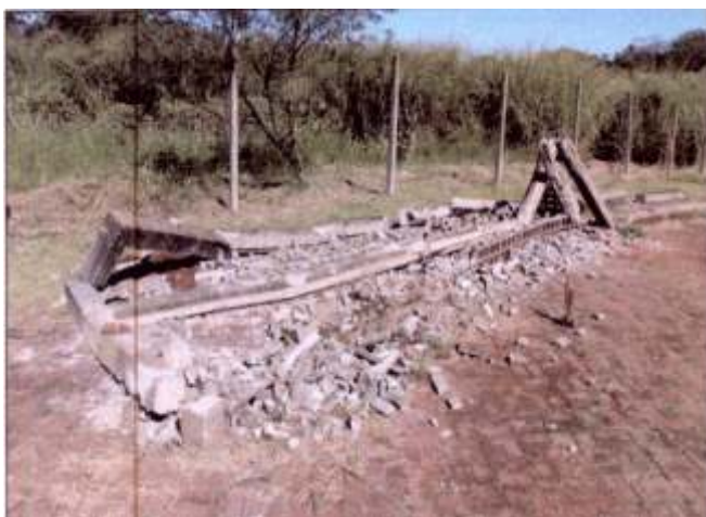
Figura 3 – Desabamento de pórtico ornamental com vítima fatal.
