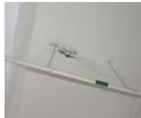
Figura 7 Manifestação patológica 07 Foco de infiltração na laje da garagem
