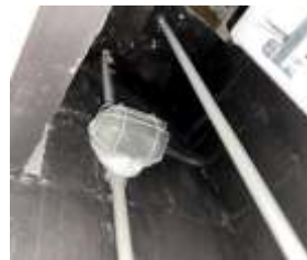
Figura 7 Manifestação patológica 07 Foco de infiltração na laje da garagem
